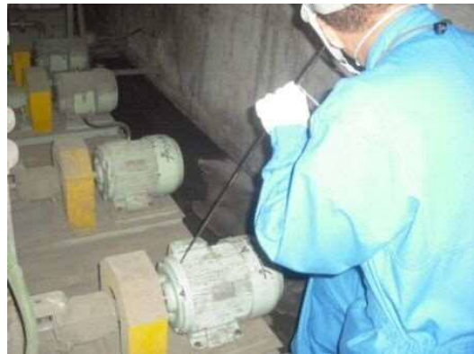
写真 13 聴診棒でベヤリング異音確認
