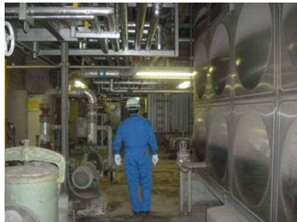
写真2 日常点検 巡視
