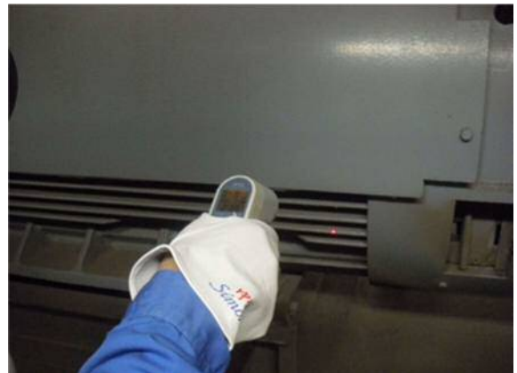
写真3 放射温度計による過熱状態確認
