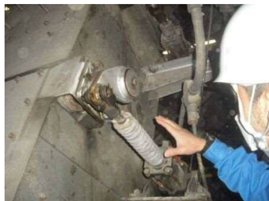
写真9 エア一漏れを確認
