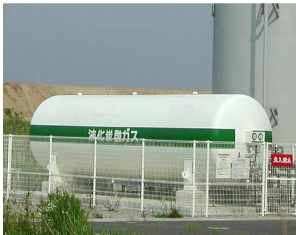
液化炭酸ガス貯槽
