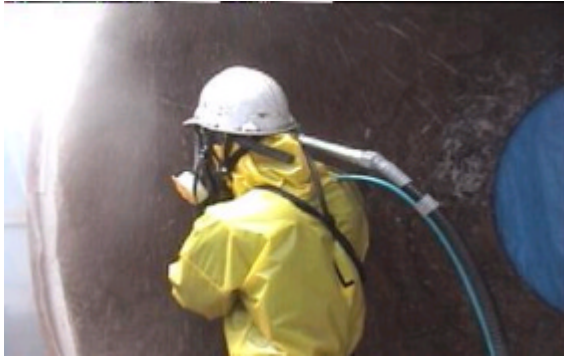
写真1 WJ洗浄(クレンナー除去)
